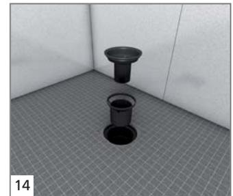
14 Carreler l'élément. Placer le siphon et la fermeture anti-odeur.
