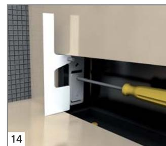
14 Placer le gabarit d'ajustage avec l'ouverture sur la fixation latérale et desserrer légèrement les vis. Aligner maintenant la suspension de sorte que le gabarit se trouve dans la continuité du carrelage mural et repose sur le carrelage au sol, ...
