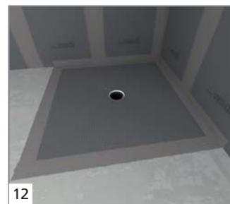
Étancher toutes les jonctions, raccords et percements en utilisant de la bande d'étanchéité et du badigeon d'étanchéité.
