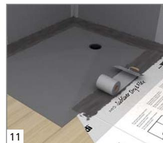
11 Traiter les jonctions et zones de raccords au plancher en bois avec le kit d'étanchéité Fundo. Recommandation : l'ensemble de la zone du plancher en bois doit être traité avec la natte d'étanchéité wedi Dry & Flex.
