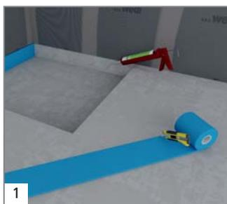
1 Mise en œuvre de la bande de rive en périphérie de la réservation. Collage avec le mastic wedi 610.
