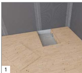
Découper la partie nécessaire du plancher pour la pose de l'écoulement.
