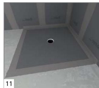
11 Traiter toutes les jonctions en utilisant notre kit d'étanchéité ou un Spec (type Mapegum de Mapei).
