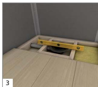
3 ... et contrôler le positionnement de l'écoulement.
