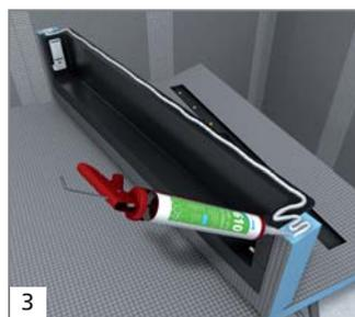
3 Positionner l'élément Discreto et appliquer une petite quantité de colle polymère wedi 610 (Important : appliquer aussi de la colle sur le côté en mousse !)
