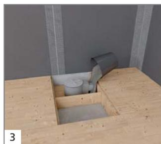
Le corps du siphon est bloqué avec un mortier de scellement. La zone de l'écoulement doit être absolument étanche.
