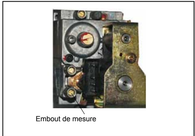
Illustration : contrôle de la pression de raccordement au gaz
