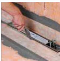
=> 3. Garnir de mortier-colle la sous-face du cadre puis poser le revêtement
