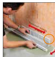
=> 1. Ajuster le support de caniveau
