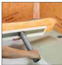
=> 2. Mettre en place le tuyau d'évacuation
